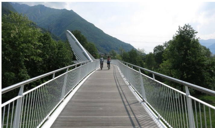
Pont réservé à la mobilité piétonne et au trafic cycliste entre Monte Carasso et Bellinzone (TI)
