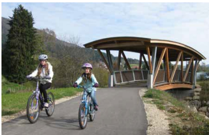
« Pont sur la Birse » destiné aux cyclistes entre Loveresse et Valbirse (BE)
